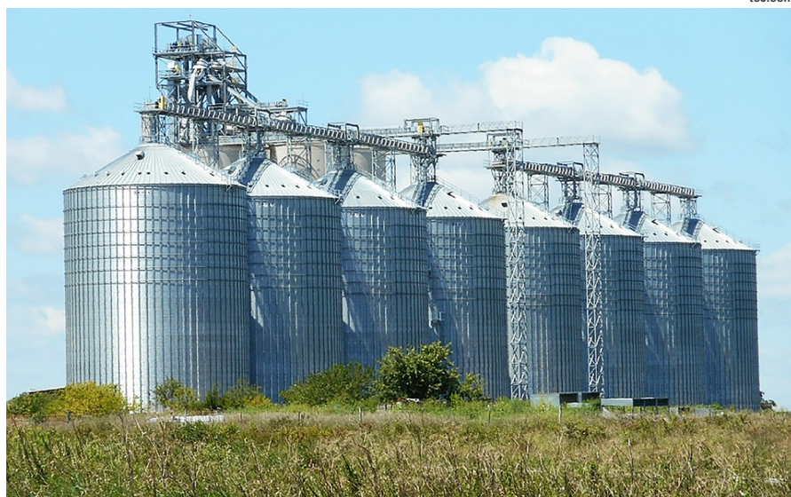
Aloizio Mercadante: “Com ampliação da capacidade de armazenagem, colocamos em prática a determinação de fortalecer ainda mais a produção agrícola brasileira”
